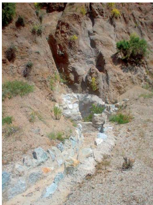
Protección de Desagües
