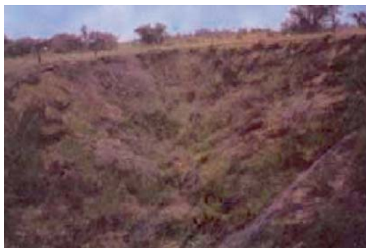
Fase de establecimiento de la hidrosiembra en el control de cárcavas.
