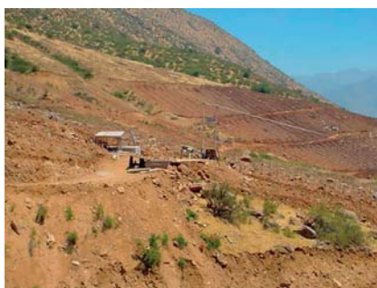
Comenzar los trabajos temprano y desde las partes más altas
