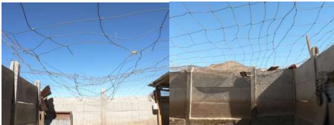
Foto 2. Corral de la Sra. Ángela Copa. A pesar que el corral (1,65 mt. de altura) estaba cubierto con malla Ursus, el depredador logra entrar rompiendo las uniones de la malla. Se observan dos aberturas donde pudo entrar y salir.
