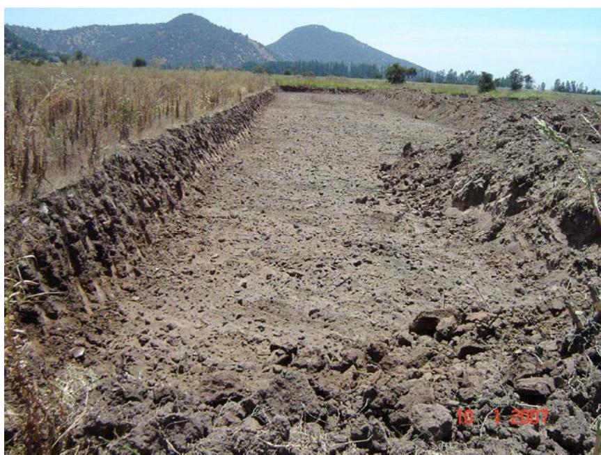
Fotografía B.2.1.b. Vista de faja de escarpe. Esta faja tiene un ancho de, 10 metros, y un espesor de 1,5 m de profundidad, donde comienza la estrata arenosa.
