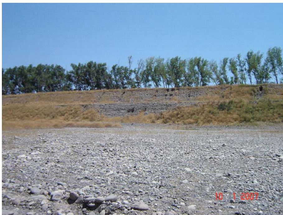
Fotografía B.1.1.b. Vista general del piso del pozo (con ripio a la vista) y taludes con erosión en progreso.
