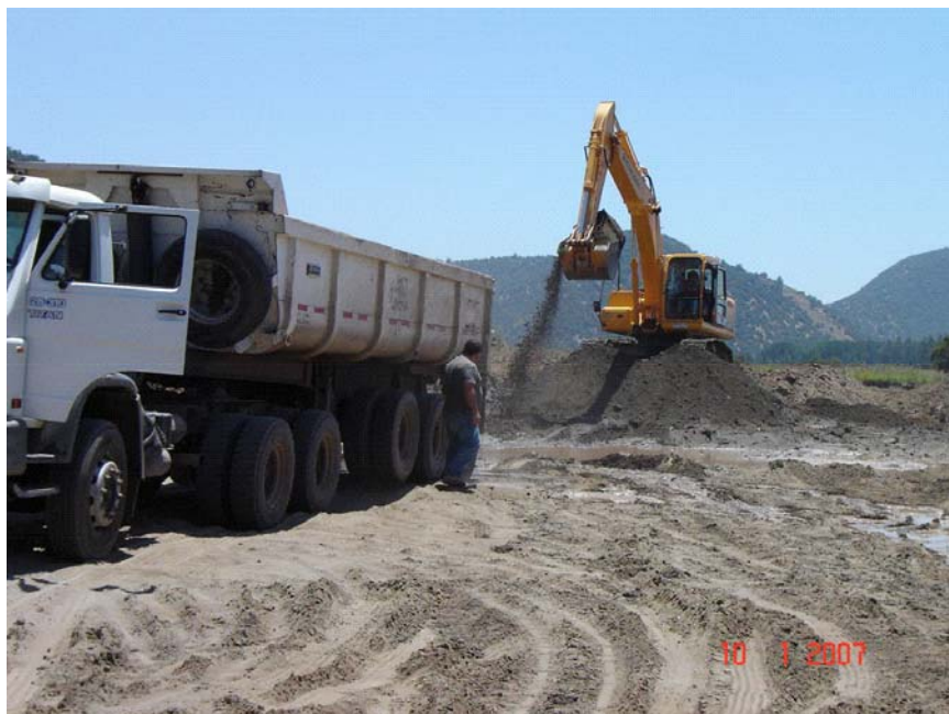
Fotografía B.2.1.e. Retroexcavadora cargando camión para retiro periódico de material, lo que se traduce en ausencia de acopios permanentes.
