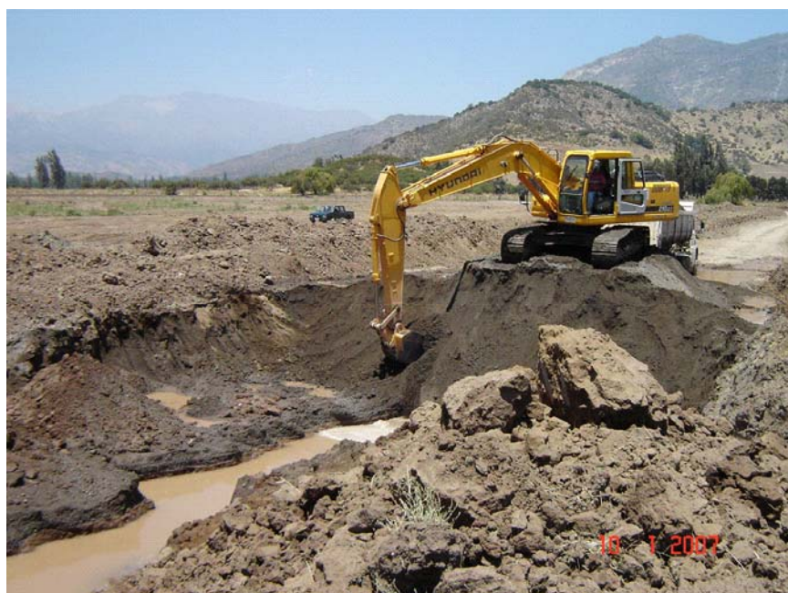
Fotografía B.2.1.d. Retroexcavadora acopiando material arena desde el subsuelo.
