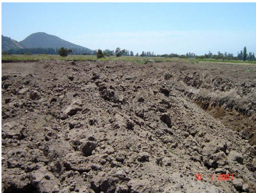
Fotografía B.2.1.c. El material de escarpe extraído de la faja de trabajo, se deposita sobre la faja en abandono, verificándose una diferencia de cota entre ambos sectores.
